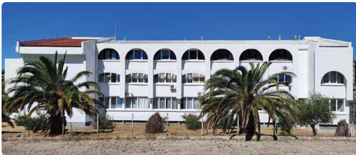
Zgrada Centra za suptropske kulture, Bar
